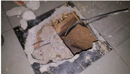
Kuva 11. Rakenneavaus välipohjaan, VP3.
