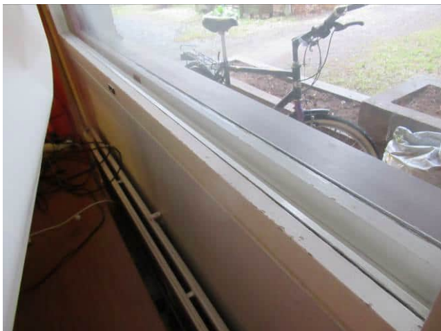
Kuva 6.22 Yleiskuvaa rakennuksen ikkunoista.
