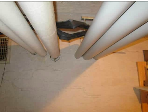
Kuva 6.71 Alkuperäistä ja uusittua eristystä kellaritilassa
