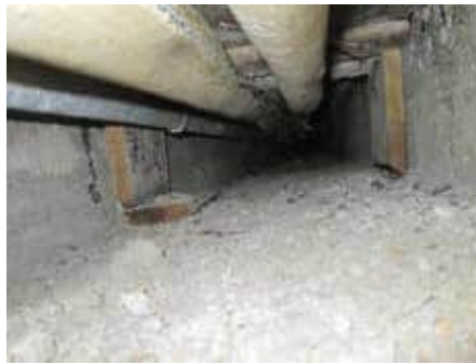
Kuva 10: Putkikanaalin avauspiste B, käytävän suuntaan kuvattuna.
