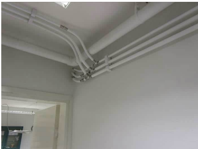
Kuva 6.45 Uusittua komposiittiputkea eläinlääkäritiloissa
