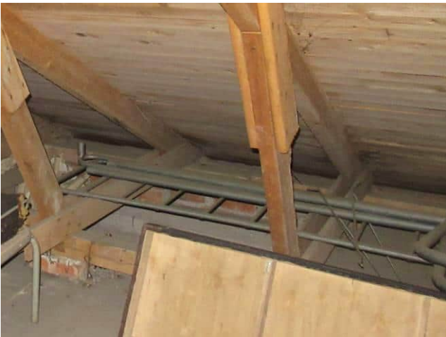
Kuva 6.30 Räystäään suuntainen tuuletusrako.
