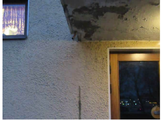
Kuva 6.4 Pääoven katoksen vedet ohjataan suoraan maahan.
