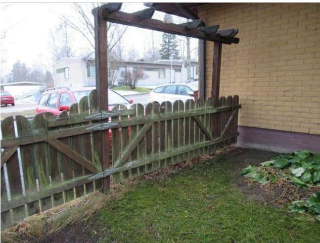
Kuva 6.14 Väliaidalle suositellaan huoltomaalausta.
