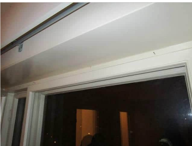
Kuva 6.78 Ikkunoissa ei ollut havaittavissa korvausilmaventtiileitä
