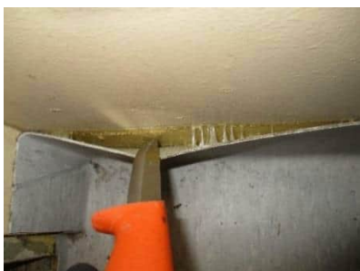
Kuva 70. Muovimaton takana kirkasta liimaa (ei sisällä asbestia).
