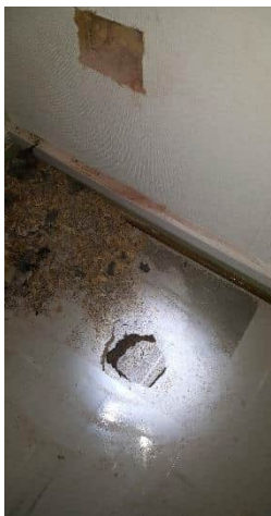
Kuva 13. Rakenneavaus välipohjaan ja ulkoseinään, VP1 ja US1.
