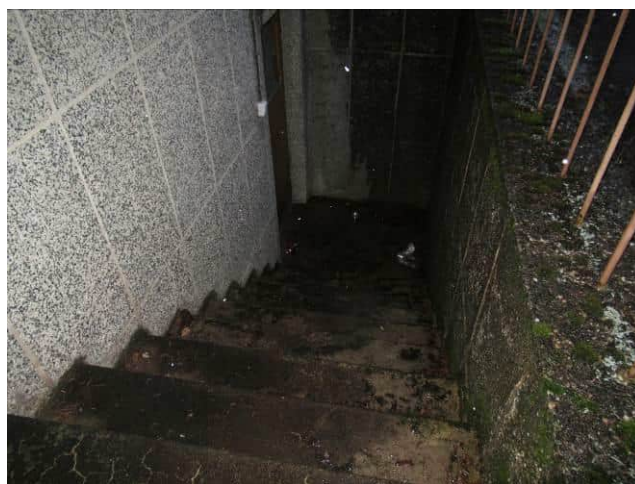
Kuva 6.13 Kellariin menevän ovisyvennyksen reunassa on betonirakenteinen tukimuuri.
