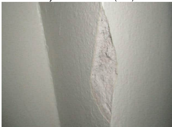
Kuva 79. Näyte seinä-/kattomaalista (Pb5).
