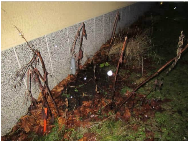
Kuva 6.14 Yleiskuva rakennuksen sokkelista.
