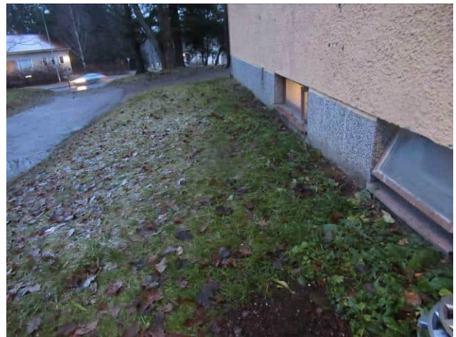
Kuva 6.10 Nurmialue ulottuu rakennuksen seinään asti.
