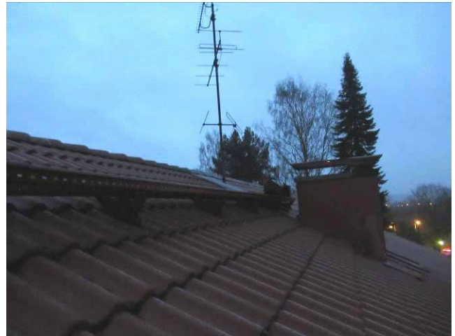
Kuva 6.36 Katolla on asianmukaiset kulkusillat.
