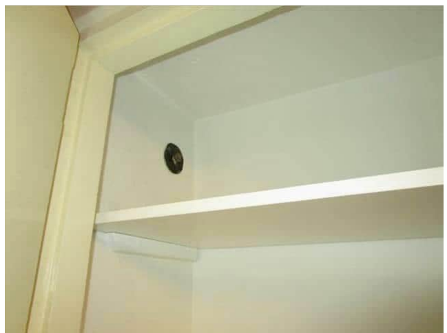
Kuva 6.79 Vanhat korvausilmareiät on paikattu.
