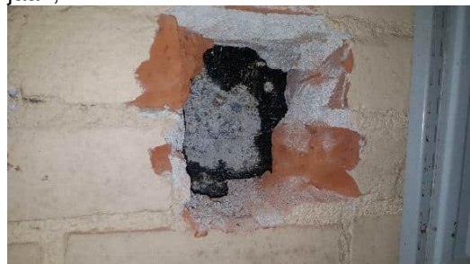
Kuva 15. Rakenneavaus kellarin seinään, KS1.
