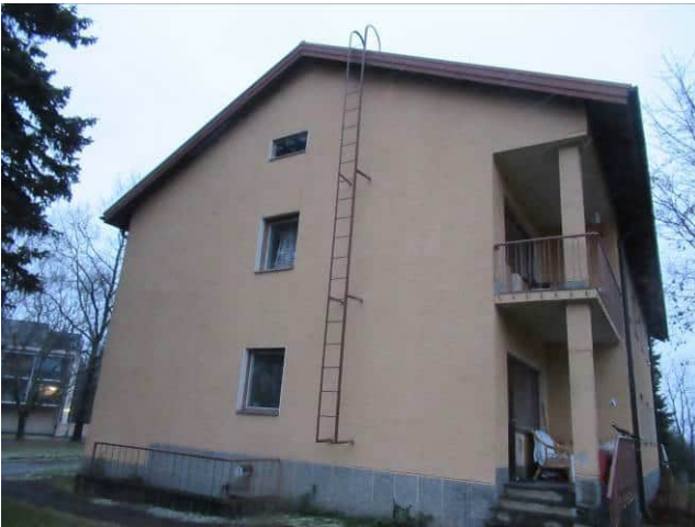
Kuva 6.35 Talotikkaat rakennuksen päädyssä.
