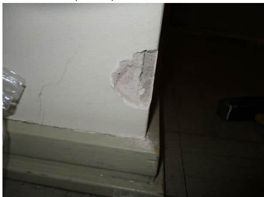
Kuva 51. Näyte seinätasoitteesta (ASB5), ei sisällä asbestia.
