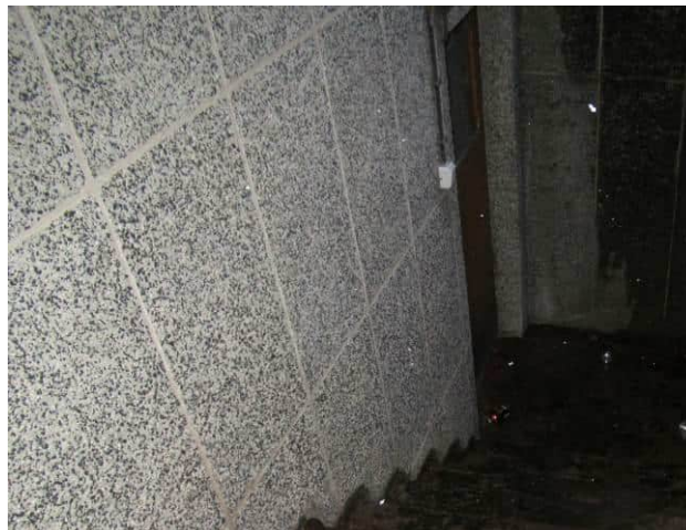
Kuva 6.15 Kellarin seinän ulkopinnassa on kivilevyt.
