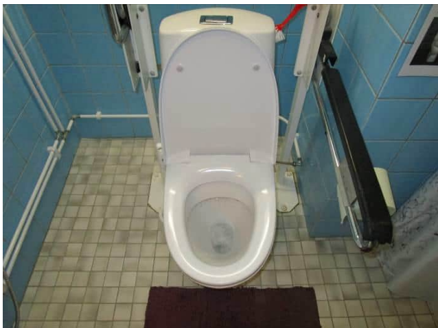
Kuva 6.49 Hyvässä kunnossa oleva WC-istuin.
