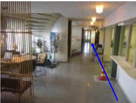
Kuva 11: Yleiskuva aulatilasta, putkikanaalin sijainti
